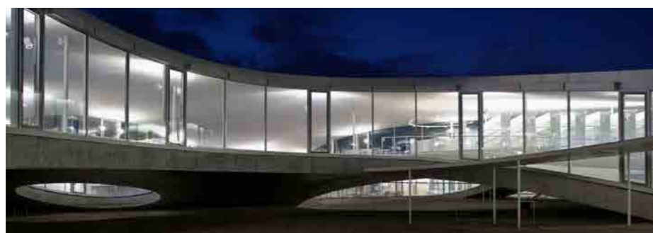
Видовая галерея второго яруса, минимизация точек опирания
