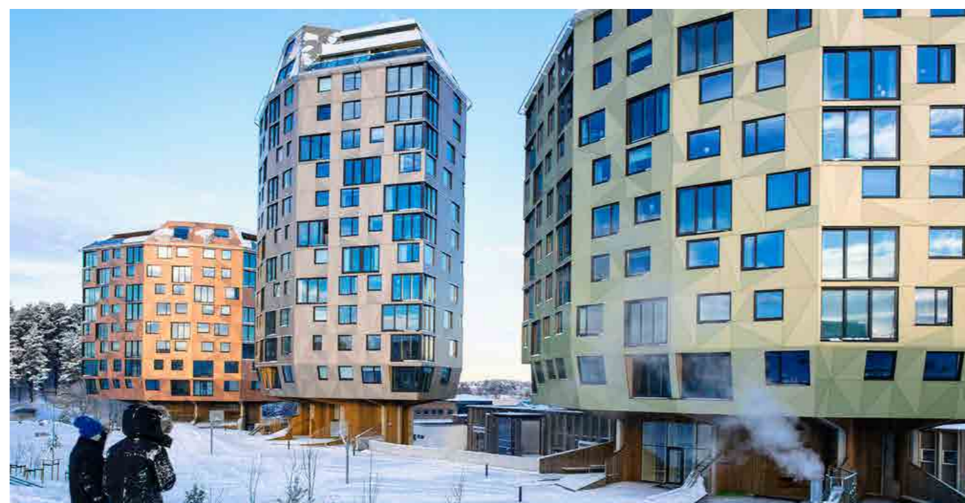
Жилой дом с использованием гибридных конструкций из бетона и дерева. Рундскоген, Норвегия Применяемые технологические решения: солнечные коллекторы на крыше, рекуперация тепла из серой воды и тепловые насосы, использующие грунт, которые обеспечивают отопление.
