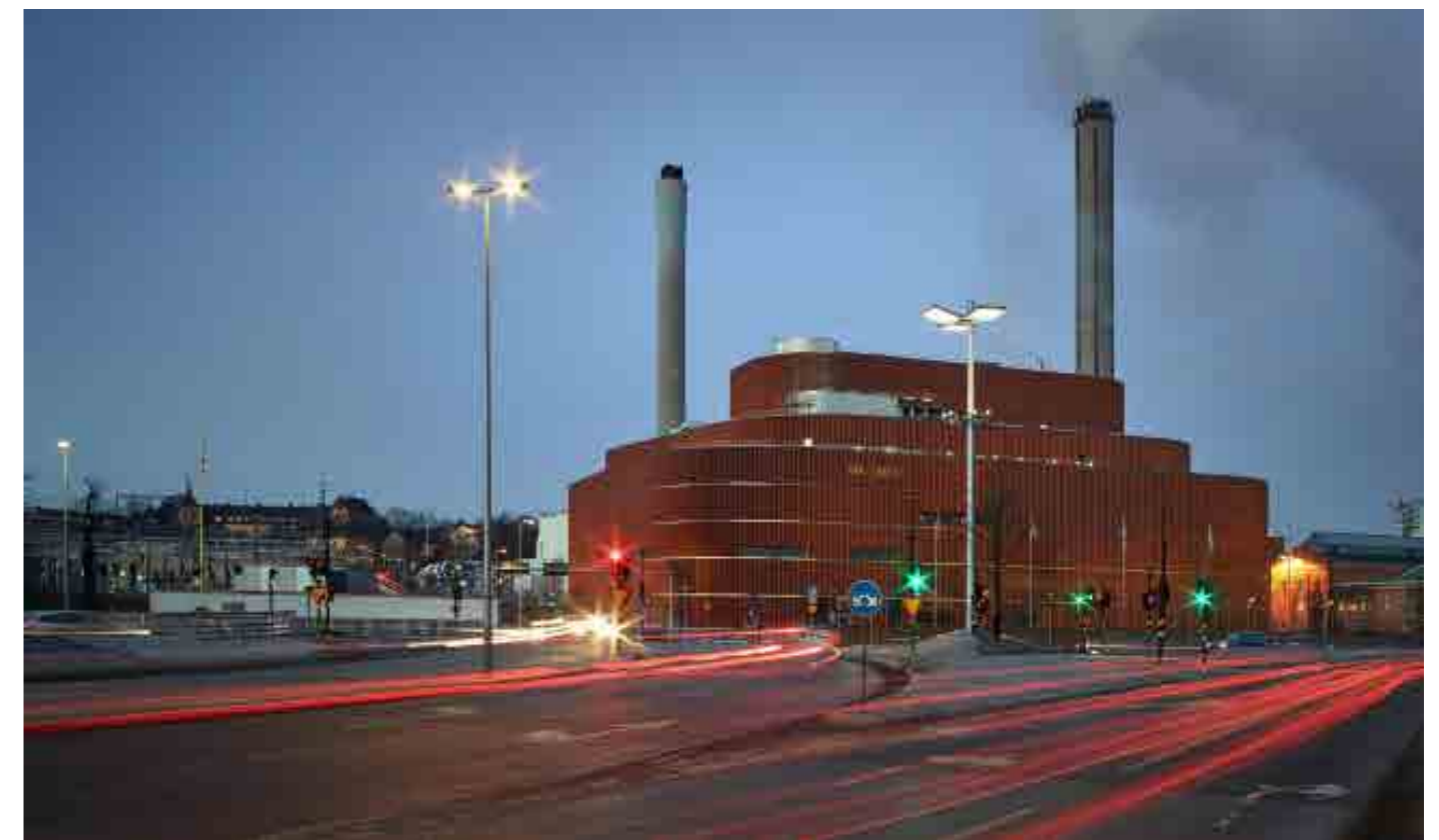
ТЭЦ на биотопливе KVV8, Стокгольм, Швеция
