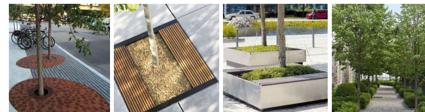
Металлические щиты Деревянный настил и евродрога Контейнер с поднятым грунтом Кустарники
