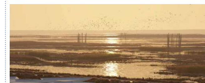
Третья очередь берегозащитных укреплений
