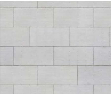
Уличные гранитные блоки Мансуровский гранит, встроенные линейные светильники
