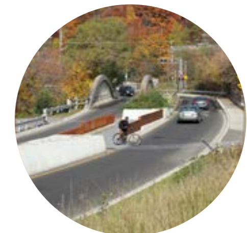
Объездная дорога на правом берегу
