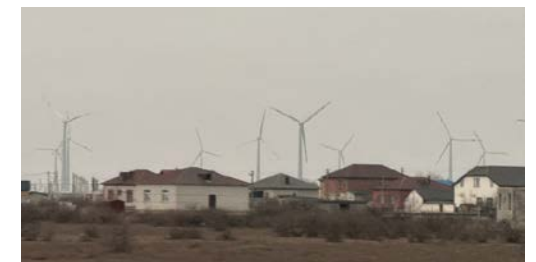
1.2. Квартальная жилая застройка с приусадебным участком
