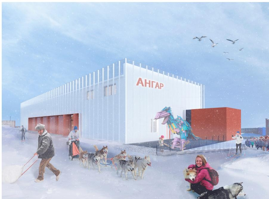
В уровне кровли сетка выполняет функцию снегоудержания. В концепции применены сэндвич-панели Rukki с эффективным утеплителем 200 мм. Аналогичные (только кровельные) панели укладываются на кровлю.
